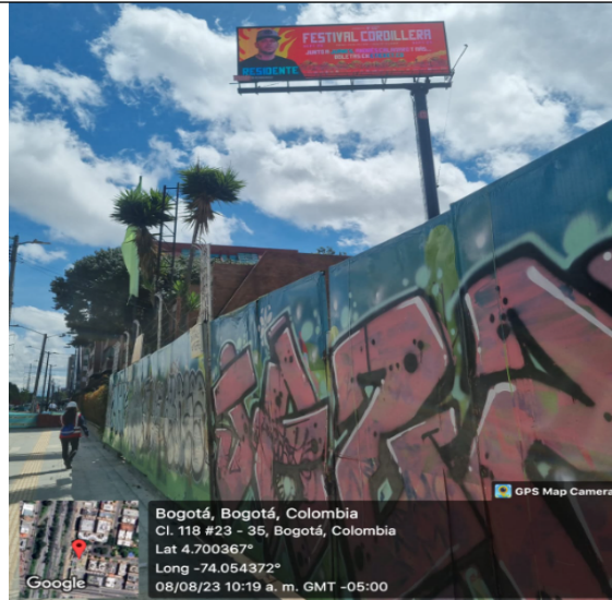
Foto 1. Vista del panel orientación SUR – NORTE y de la estructura de la valla con innovación tecnológica, ubicada en el predio Calle 118 No. 23 – 35 (dirección catastral), en buenas condiciones y estable.
